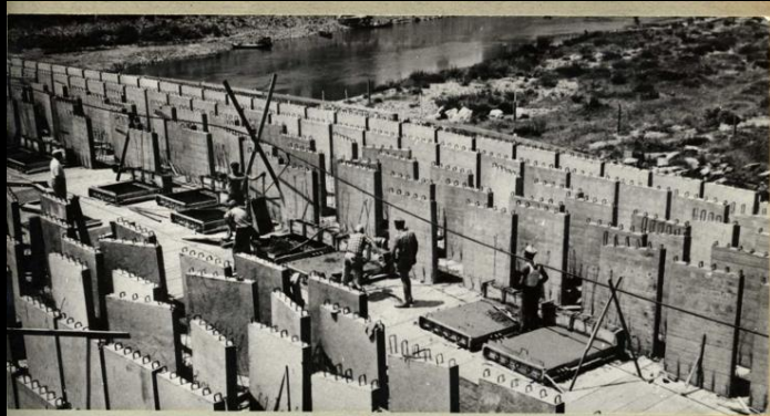
- I "conci" prefabbricati per la costruzione delle travate tubolari.
