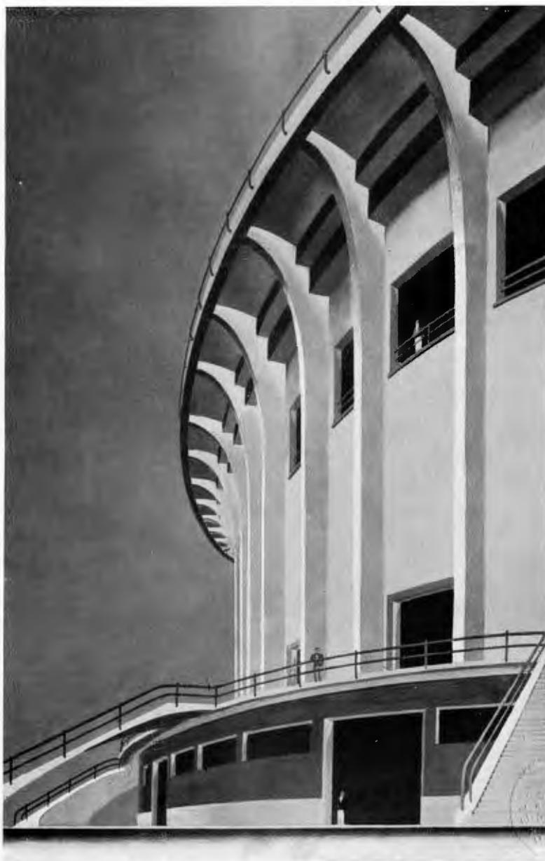
*PARTICOLARE PROSPETTICO. - Le grandi rampe di scale servono per accesso al primo ripiano perimetrale. La superficie esterna al di sopra del ripiano è in intonaco chiaro inalterabile. La parte basamentale in rivestimento di travertino. Le ringhiere in acciaio inossidabile.*
